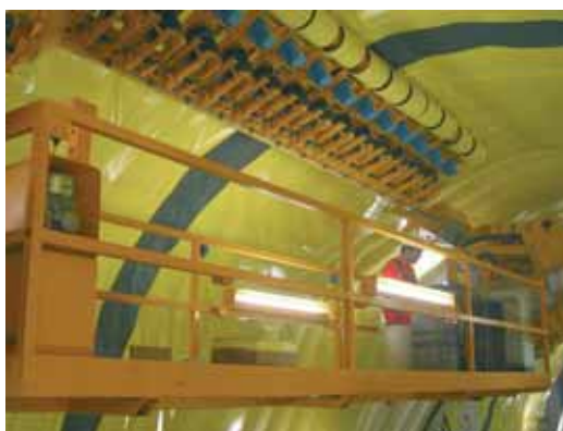
Automatische Verlegung der Folie mittels Anpressbalken
