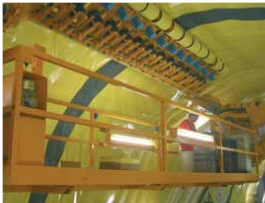
Automatische Verlegung der Folie mittels Anpressbalken
