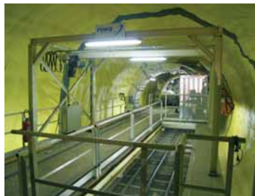
Beschickung Folie ab Streckengleis auf Wurmino
