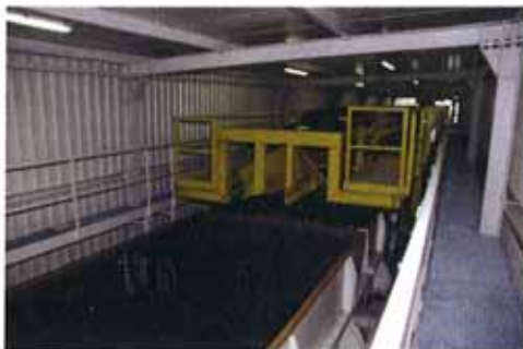
Bahnverladeanlage innen, oben
