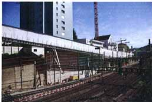
Streckenbandanlage Kies und Ausbruch
