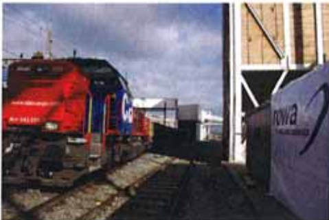
Abtransport von Ausbruch
