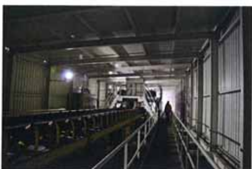
Bunker Ansicht innen oben beim Trichtereinwurf
