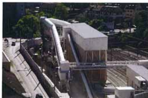
Bunker Ansicht von aussen
