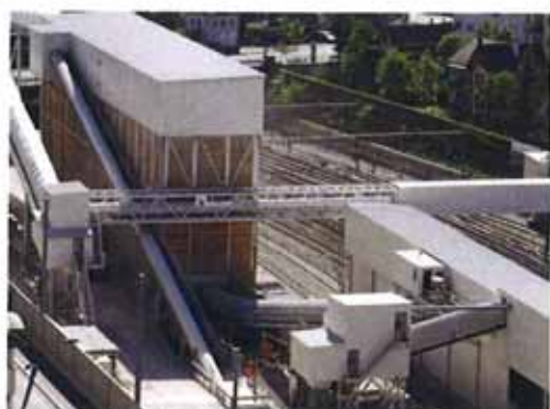
Zuführ- und Querband zu Bahnverladeanlage
