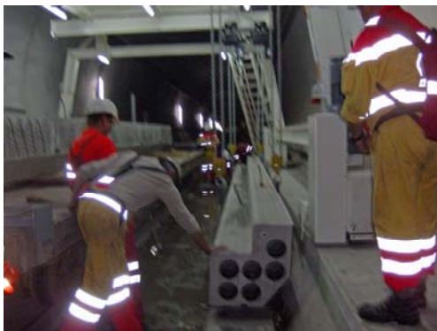
Absetzen des Elementes auf vorbereiteten Betonsockeln
