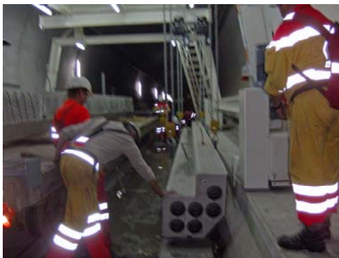
Absetzen des Elementes auf vorbereiteten Betonsockeln
