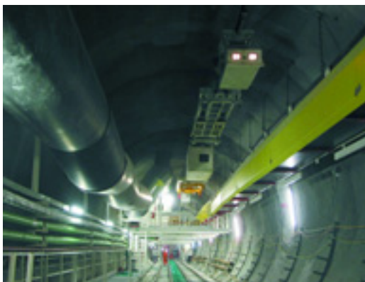
Am Tunnelfirst aufgehängter Monorail
