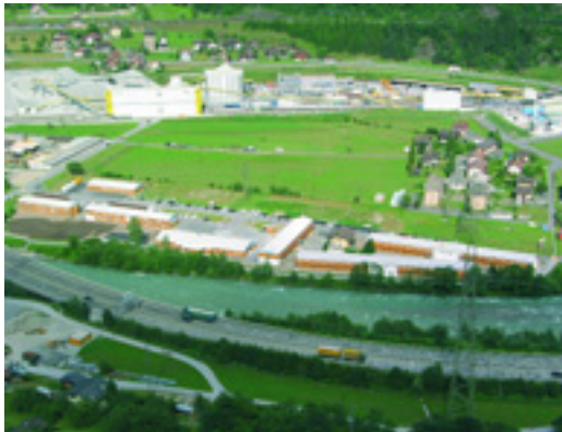
Baustelle Amsteg Los 252
