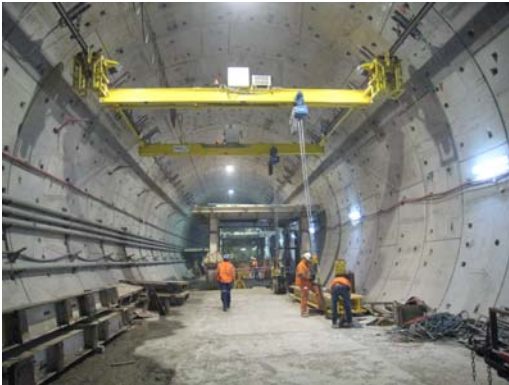
Demontagekran in Betrieb
