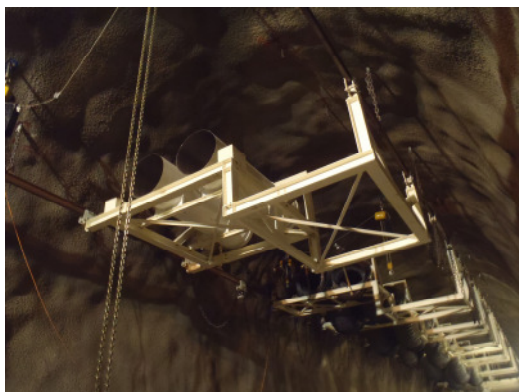
Ventilationsbühne während der Baustellenmontage
