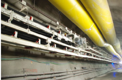
Übergabe des Ausbruchmaterials vom Schleppband auf das Transferband
