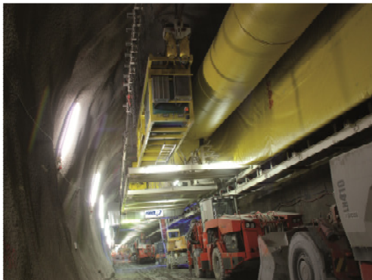
Vortriebsinstallation, Förderbänder und Monorail, parkierte Baugeräte im Tunnelquerschnitt
