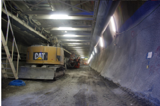
Grosszügiger Arbeits-, Manövrierver- und Parkraum auf der Sohle
