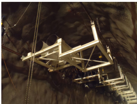
Ventilationsbühne während der Baustellenmontage
