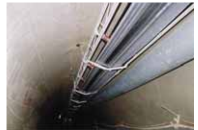
Bandstrecke im Pilotstollen
