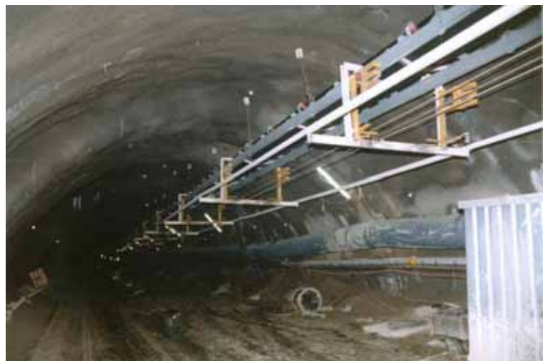
Bandspeicher im Vorstollen
