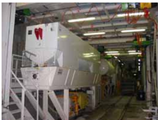
Umschlag und Zwischenspeicher von Perlkies (17 m 3 ) für Tübbinghinterfüllung
