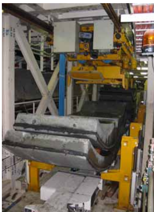
Tübbingschnellentladung, Tübbingumschlagkran mit Vakuumgreifer
