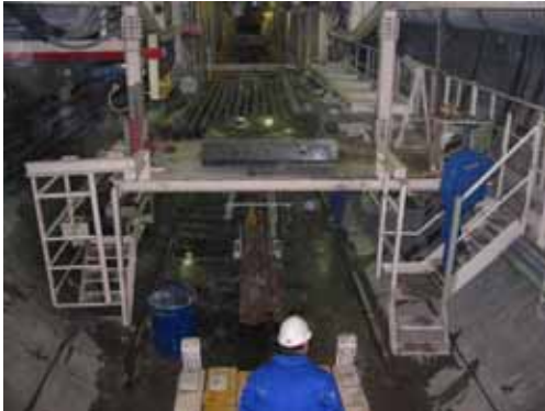
Rohrlager und -einbaustelle
