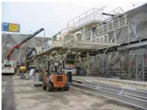
Die Anlage verlässt das Tageslicht
