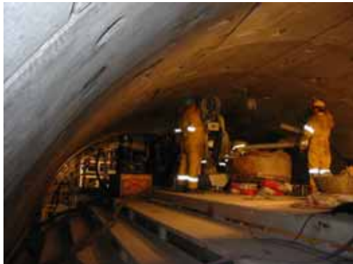
Arbeitsstelle für Tübbinghinterfüllung
