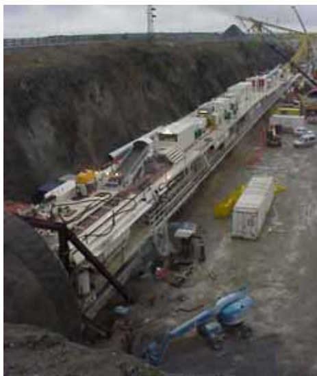
Baustellenmontage im Norden, Herbst 2002
