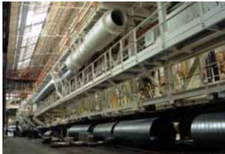
Werkmontage in Le Creusot, Frankreich
