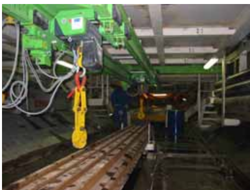
Schieneeinbaustelle mit Tagesmagazin
