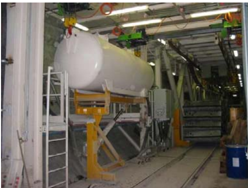
Trockenmörtelspeicher und -pumpstation
