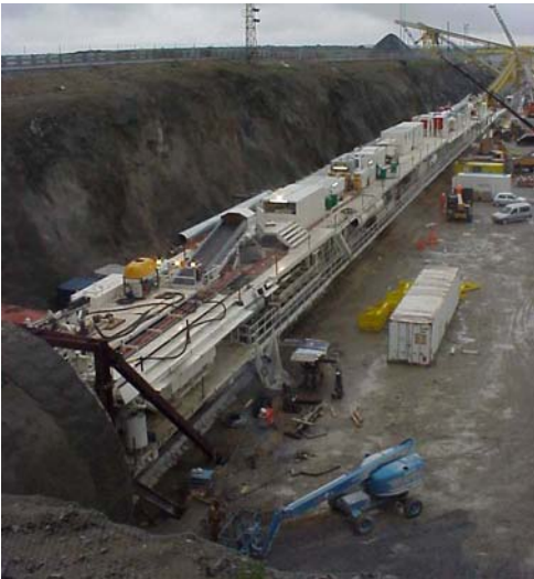
Baustellenmontage im Norden, Herbst 2002
