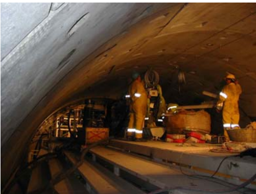
Arbeitsstelle für die Tübbinghinterfüllung
