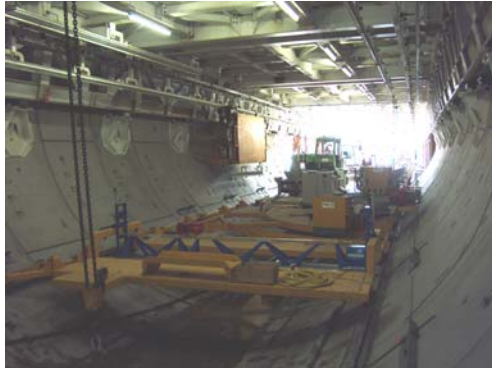
Gesamtansicht Sohlbeton Einbauanlage
