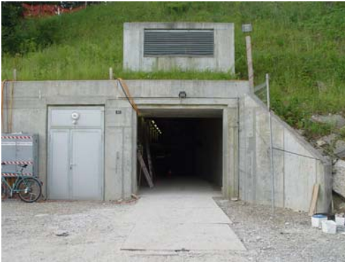
Portal Abwasserstollen Langenthal
