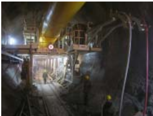
Luttenspeicher / Hochspannungstrommel
