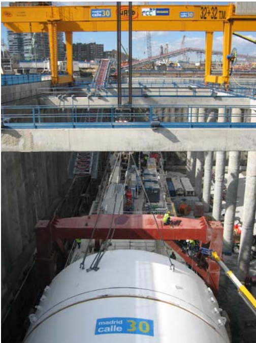
Startschacht für die Vortriebseinrichtung
