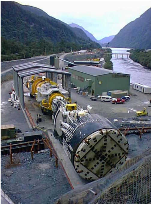
Tunnelbohrmaschine und Nachläufer vor dem Portal
