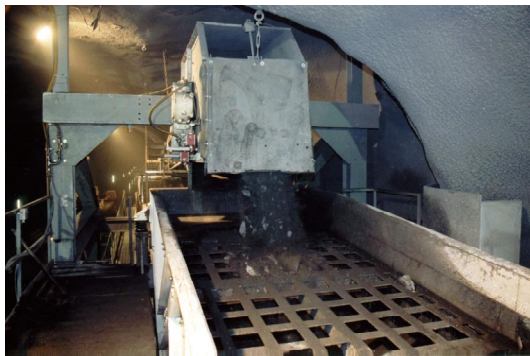
Abwurfstelle Tunnelförderband Süd im Fusspunkt
