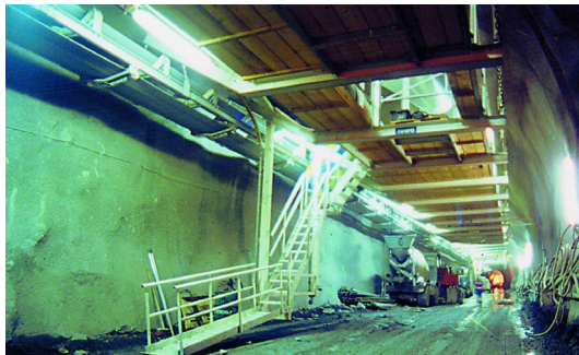
Aufstieg von der Sohle auf die Vortriebsinstallation
