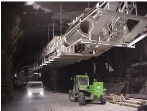
Heck der Vortriebsinstallation mit Luttenspeicher für die Frischluft- und die Sprenggasabsaugung in der Startpha-
