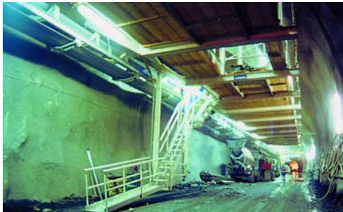
Aufstieg von der Sohle auf die Vortriebsinstallation
