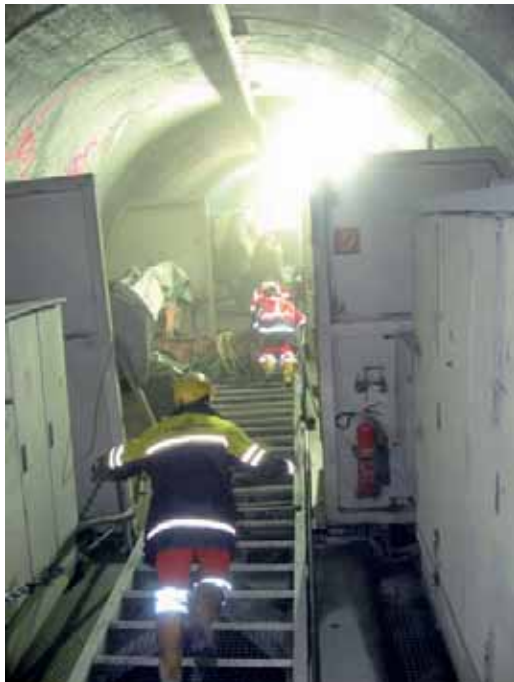
Aufstieg durch die Nachlaufinstallation
