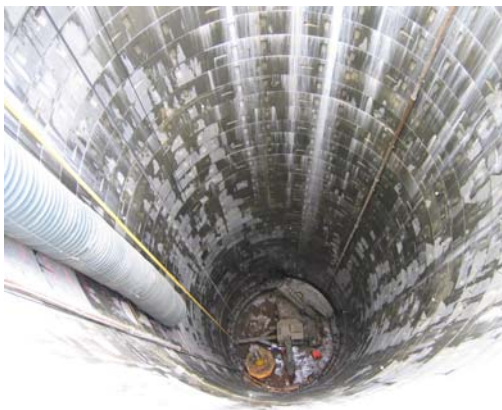
Tübbingauskleidung mit Drainagefunktion
