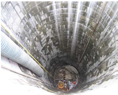
Tübbingauskleidung mit Drainagefunktion
