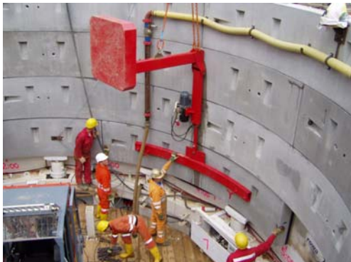
Versetzen eines Tübbing
