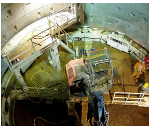
Zentrisch angeordneter Bagger als Aushub- und Abbaugerät mit Hammer
