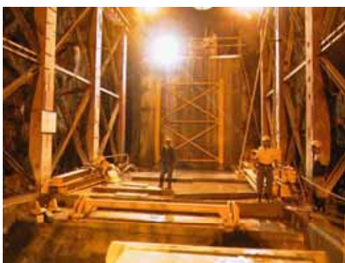
Ansicht Schachtfuss Richtung Startröhre des Schrägschachtes
