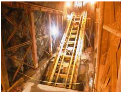
Test der Startrampe ohne TBM
