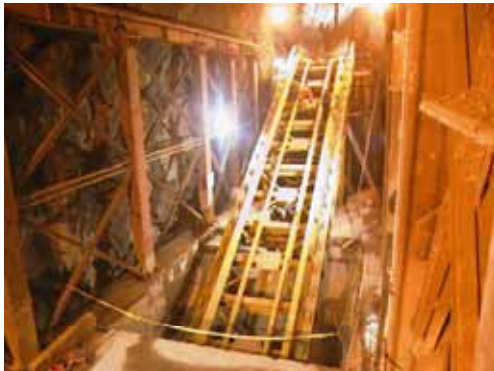
Test der Startrampe ohne TBM
