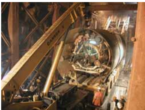
Horizontale Montage der TBM auf der Startrampe
