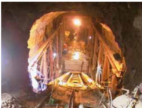
Sicht aus Startröhre Richtung Schachtfahrt
