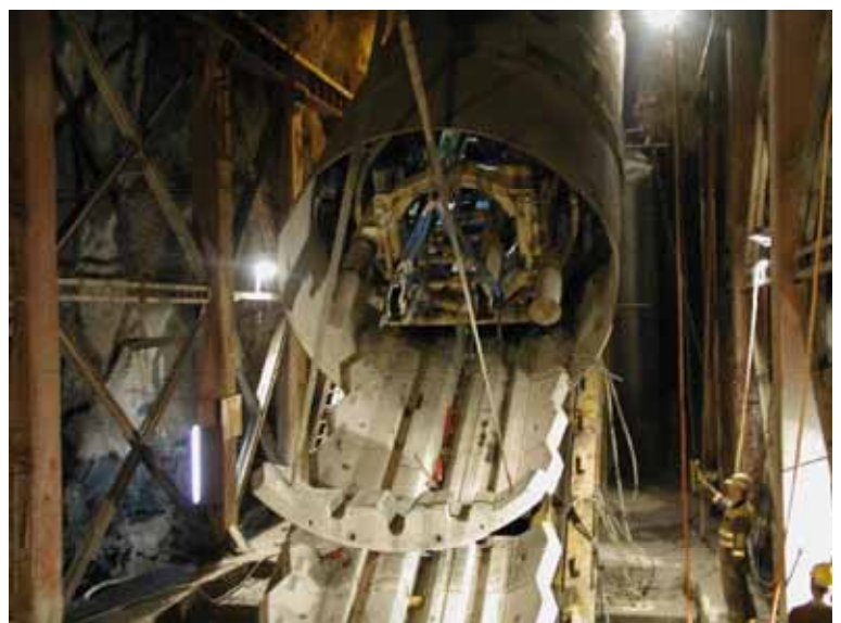
Hochschreiten der TBM nach dem Kippen in die Tunnelachse
