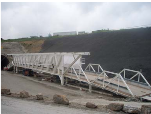
Baustellenmontage Brücke Gesamtansicht
