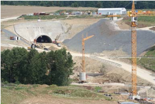
Portal Tunnel Reitersberg
