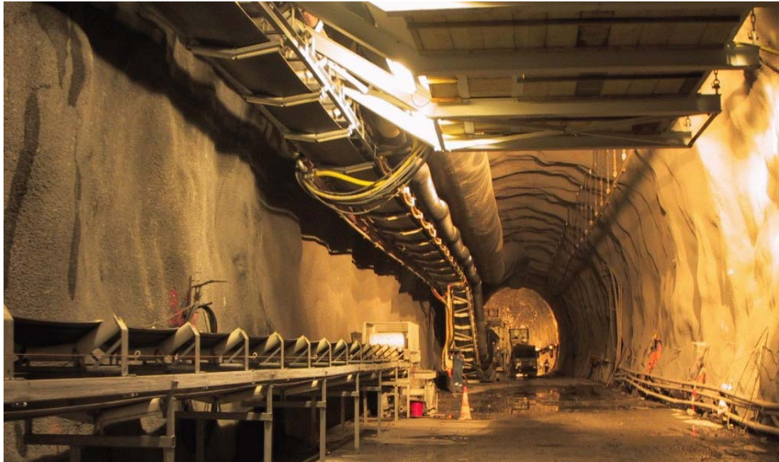
Sprengevortrieb
