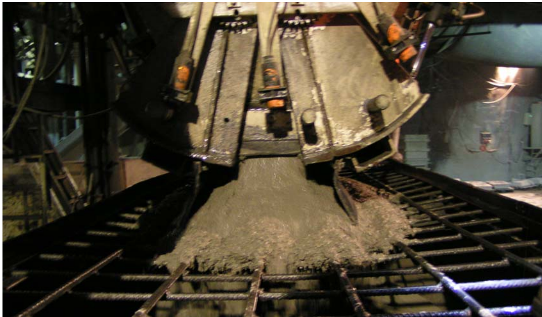
Bild: Befüllung RoCon Wagen bei der Betonanlage
