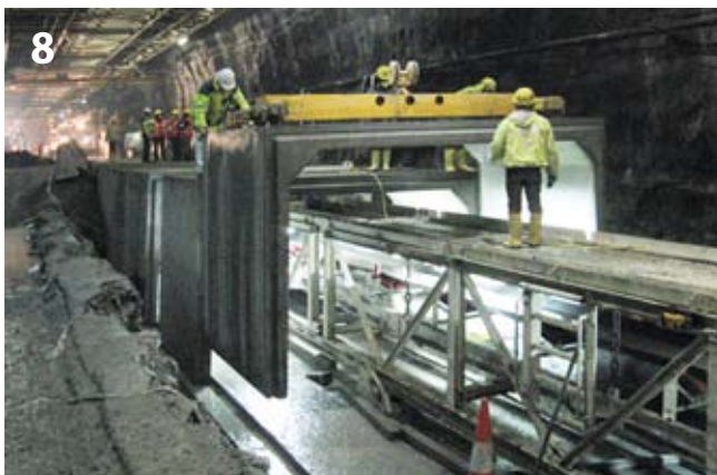
Umschlag und Einbau der Fertigelemente für den Fluchtstollen mit dem Schwerlastkran
