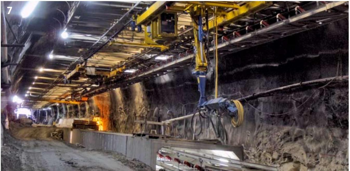
Spritzbetonmanipulator mit schwenk- und teleskopierbarem Spritzarm. Der Arbeitsbereich beträgt 12 m und 210° Shotcrete manipulator with swiveling and telescopic spraying arm. The working area covers 12 m and 210°
