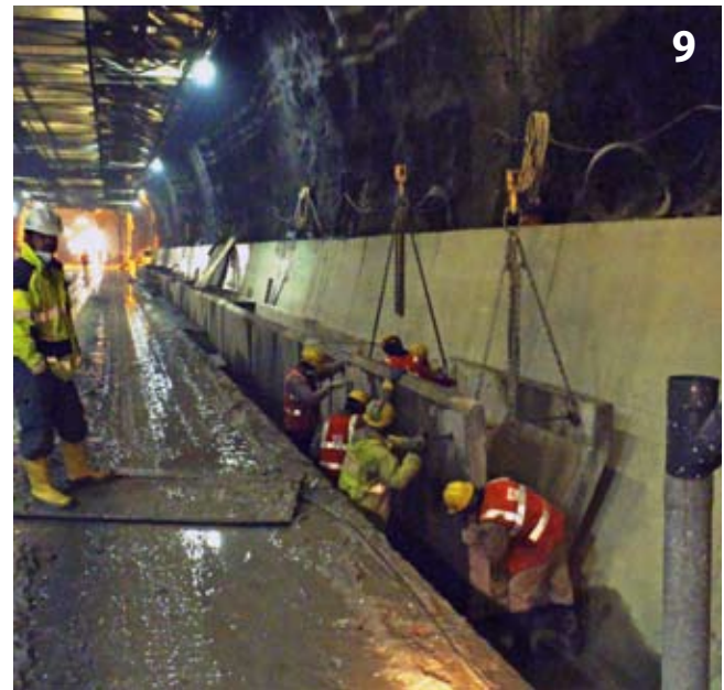
Flächenkran zum Materialumschlag, Umsetzen der Schalung für den Gewölbeanschluss und Versetzen von vorgefertigten Leitungselementen
