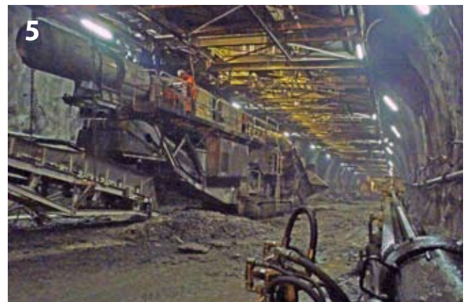
5 Vortriebsbühne, Backenbrecher und Schleppband im Bereich des Ausbruch Strosse/Sohle
