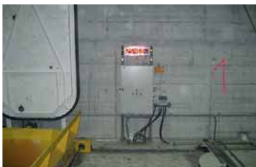
Anzeige Beladungsgewicht für Baggerfahrer
