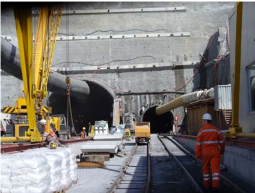
Tunnelhauptportal und Sicherheitsstollenportal
