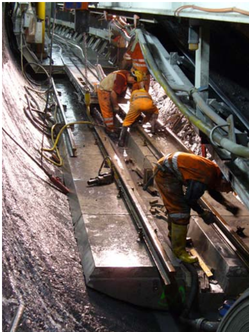
Gleiseinbaubrücke an der Frontzunge
