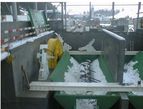
Baustellenmontage im November 2002
