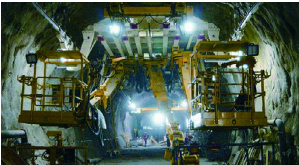
Eine konsequente Mechanisierung erhöht auch im konventionellen Vortrieb Leistung, Produktivität und Sicherheit
