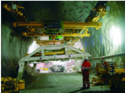
Die multifunktionale Vortriebsinstallation in der Montagephase
