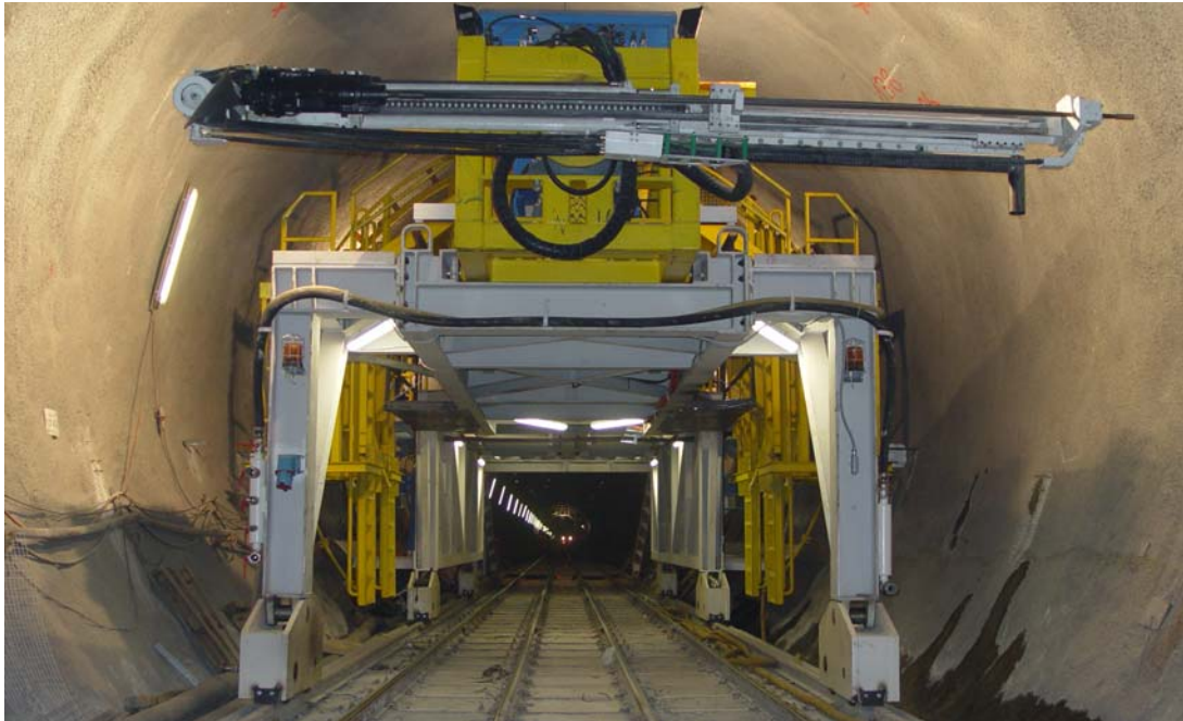
Bild: Gesamtanlage Reprofilierung
