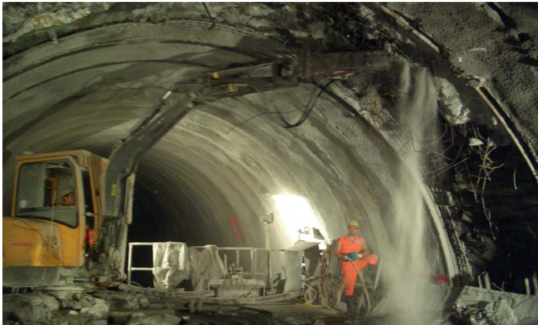
Bild: Ausbau der verformten Einbaubögen
