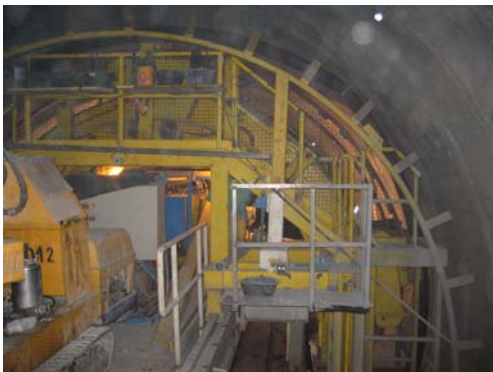
Arbeitspodest mit Bogeneinbau
