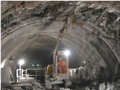
Freispitzen der Reparaturstelle
