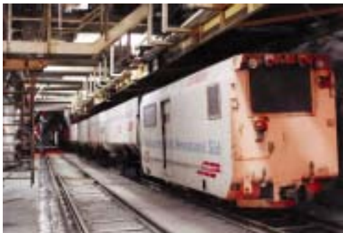
Der Schutterzug wird von der Hängebühne aus beladen. Das zweite Gleis dient als Baustellenversorgung.
