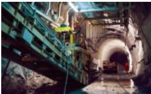
Vortrieb der Einspurstrecke
