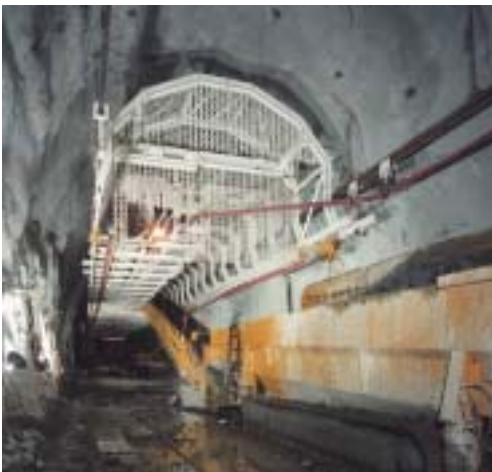
Hängebühne mit Sprengschutz (erstmalig im Tunnelbau eingesetzt)
