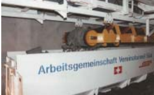
Schutterzug wird von der Hängebühne aus beladen
