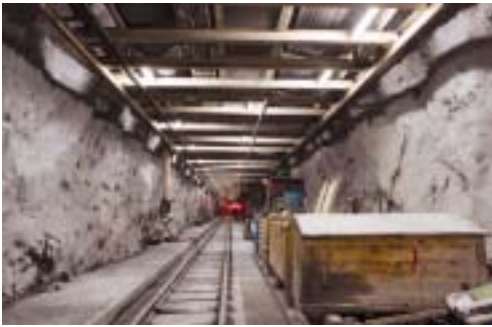
Sohlbetoneinbau unter Hängebühne
