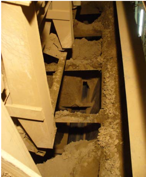
Kippbunker mit Abzugsband
