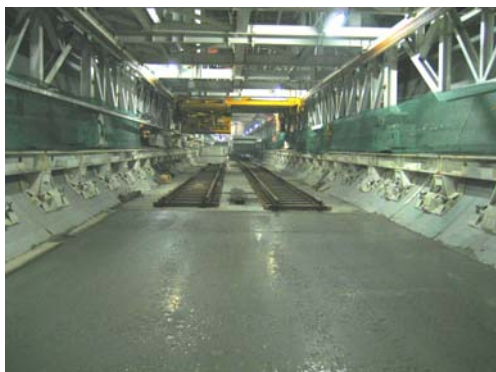
Doppelgleis bis in den Vortrieb
