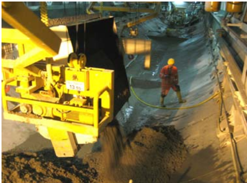
Ein Hochleistungsumschlagkran mit Kübelentleereinrichtung (360°) versorgt die Sohleinbaustelle mit Frischbeton
