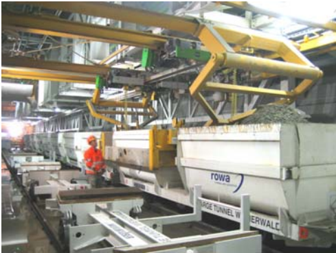
Umschlag Betonkübel mit Schnellwechslergehänge
