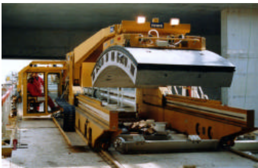
Der Tübbingzubringerwagen holt die Tübbinge auf dem Zwischenlagerplatz, wo er sie um 90 Grad dreht und dem Erekter übergibt
