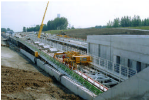
Zwischenlagerplatz mit Tübbingzubringerwagen
