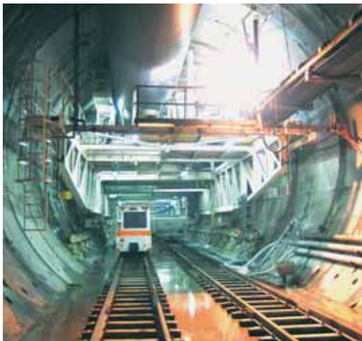
Der Nachläufer ist über die gesamte Bahnhoflänge 2-gleisig befahrbar. Dabei wird ein paralleles Versorgen des Vortriebes und des Sohleneinbaus gewährleistet
