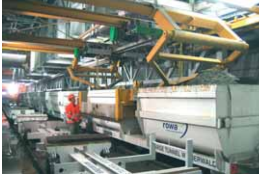
Entladung der Sohlbetontransportbehälter(4,5m³) mit Spezialkran
