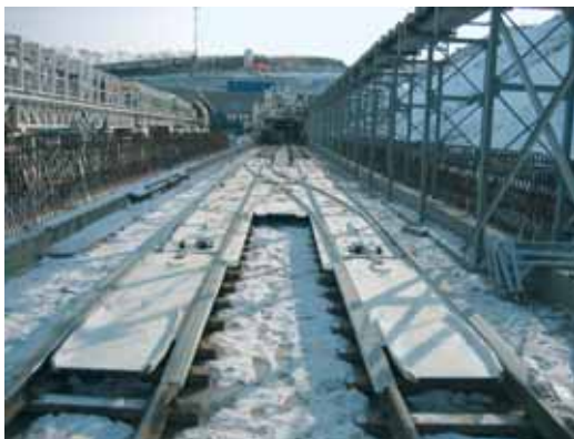
Mobile Kreuzungsweiche mit niedrigster Bauhöhe
