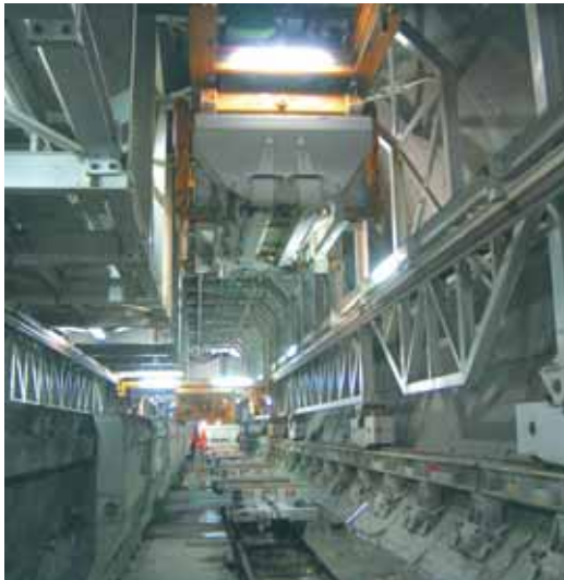
Umschlag von Sand und Bindemittel gleichzeitig mit dem Sohlbetonumschlag
