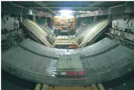
Umschlagstelle für Spezialkonsolen (für Nachläuferabstützung) und Tübbinge hinter dem Tübbingmagazin
