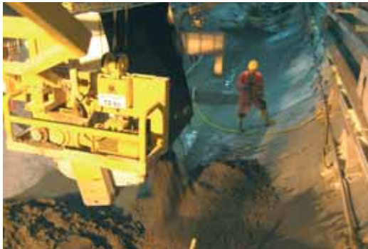
Ein Hochleistungsumschlagkran mit Kübelentleereinrichtung (360°) versorgt die Sohleinbaustelle mit Frischbeton
