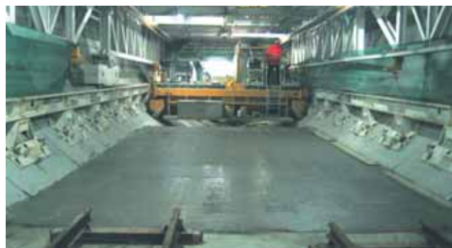
Die frisch eingebaute Betonsohle liegt bereit für den Gleiseinbau
