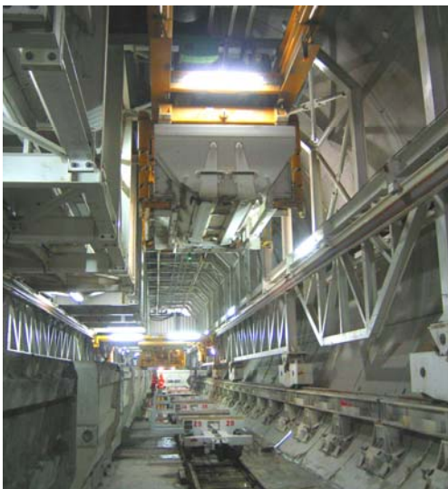
Umschlag von Sand und Bindemittel gleichzeitig mit dem Sohlbetonumschlag.
