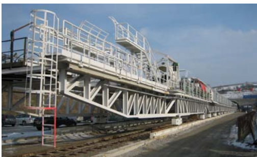
Nachlaufinstallation bereit für den Vortrieb
