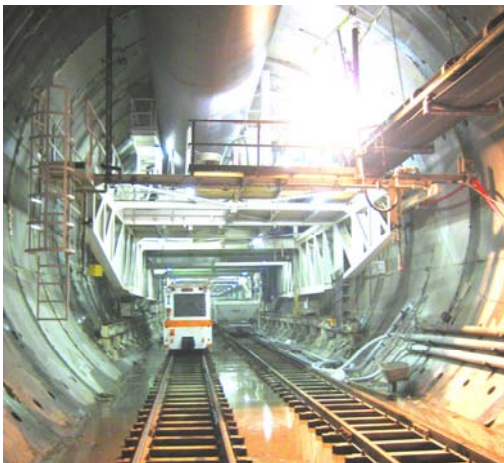
Der Nachläufer ist über die gesamte Bahnhoflänge 2-gleisig befahrbar. Dabei wird ein paralleles Versorgen des Vortriebes und des Sohleineinbaus gewährleistet
