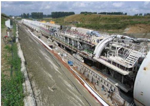
Nachlaufinstallation vor dem Portal
