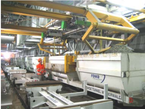
Entladung der Sohlbetontransportbehälter(4.5m³) mit Spezialkran
