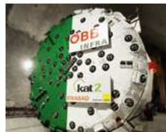
► Tunnelvortriebsmaschine in der Nordröhre
