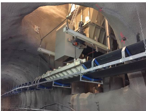
Zwischenaufgabestelle ab SPV auf Schutterband
