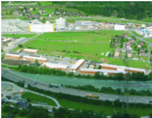
Construction site Amsteg section 252
