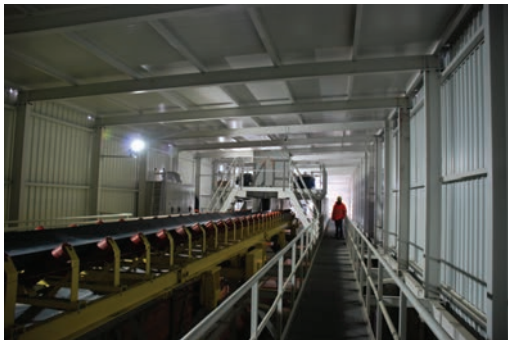
Bunker Ansicht innen oben beim Trichtereinwurf
