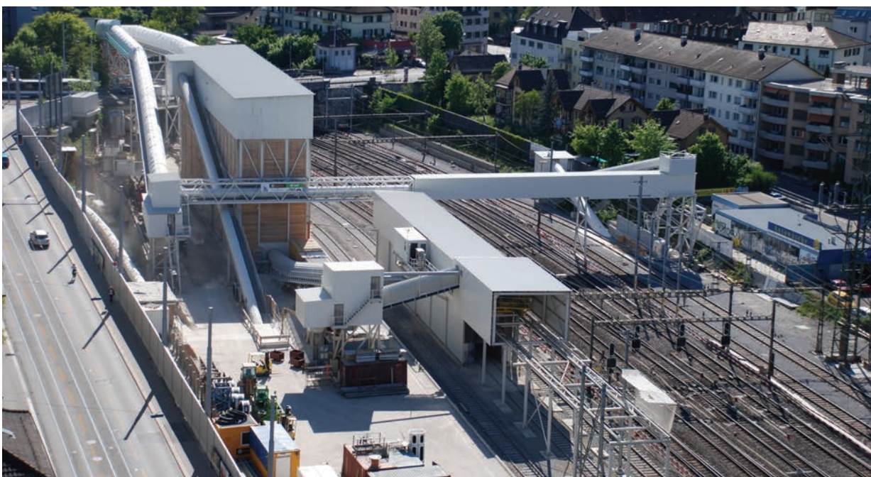
Gesamtübersicht Ver- und Entsorgungsanlage
