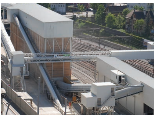
Zuführ- und Querband zu Bahnverladeanlage
