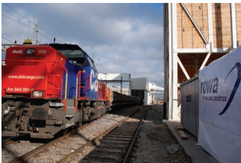
Abtransport von Ausbruch
