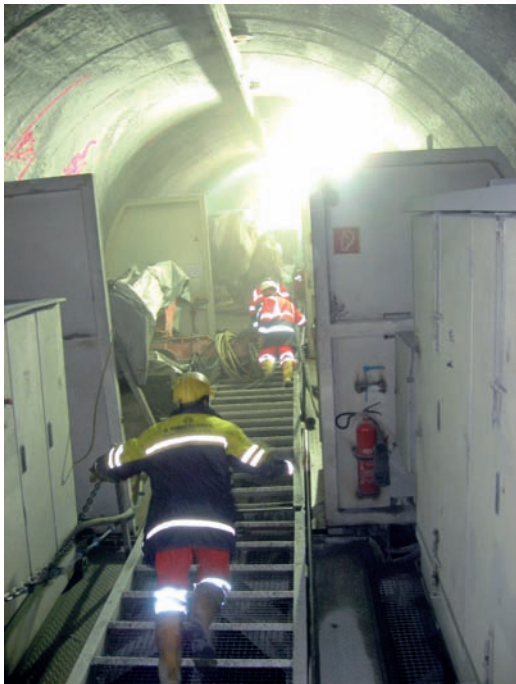
Aufstieg durch die Nachlaufinstallation
