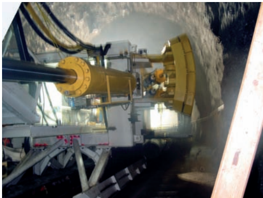
Presszylinder ausgefahren
