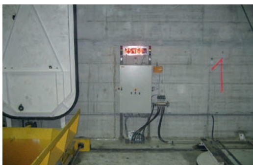
Anzeige Beladungsgewicht für Baggerfahrer
