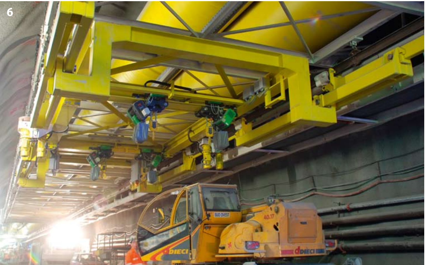
15-t-Schwerlastkran im Bereich der Sohlbaustelle. Die 66 m lange Sohlbetonbühne kann relativ zur Vortriebsbühne verfahren werden 15 t heavy duty crane in the invert construction area. The 66 m long invert platform can be moved relative to the heading platform
