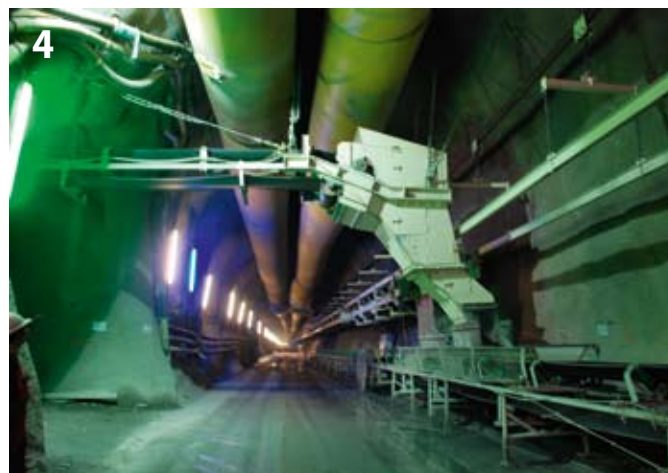
Übergabe des Ausbruchmaterials der Oströhre auf das Streckenband in der Weströhre
