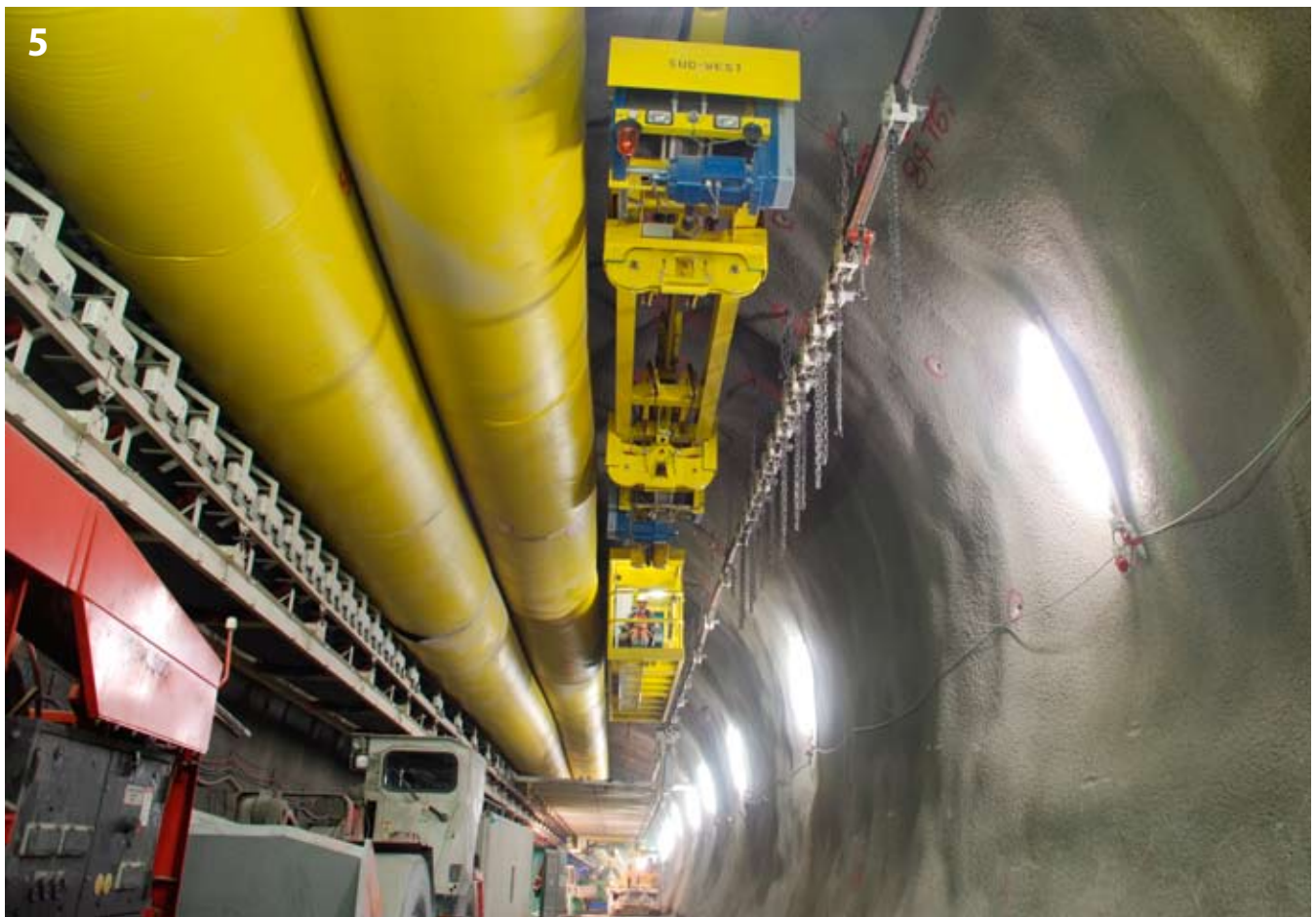
5 Monorail zur direkten Versorgung des Vortriebs Monorail for direct supply of the heading area
